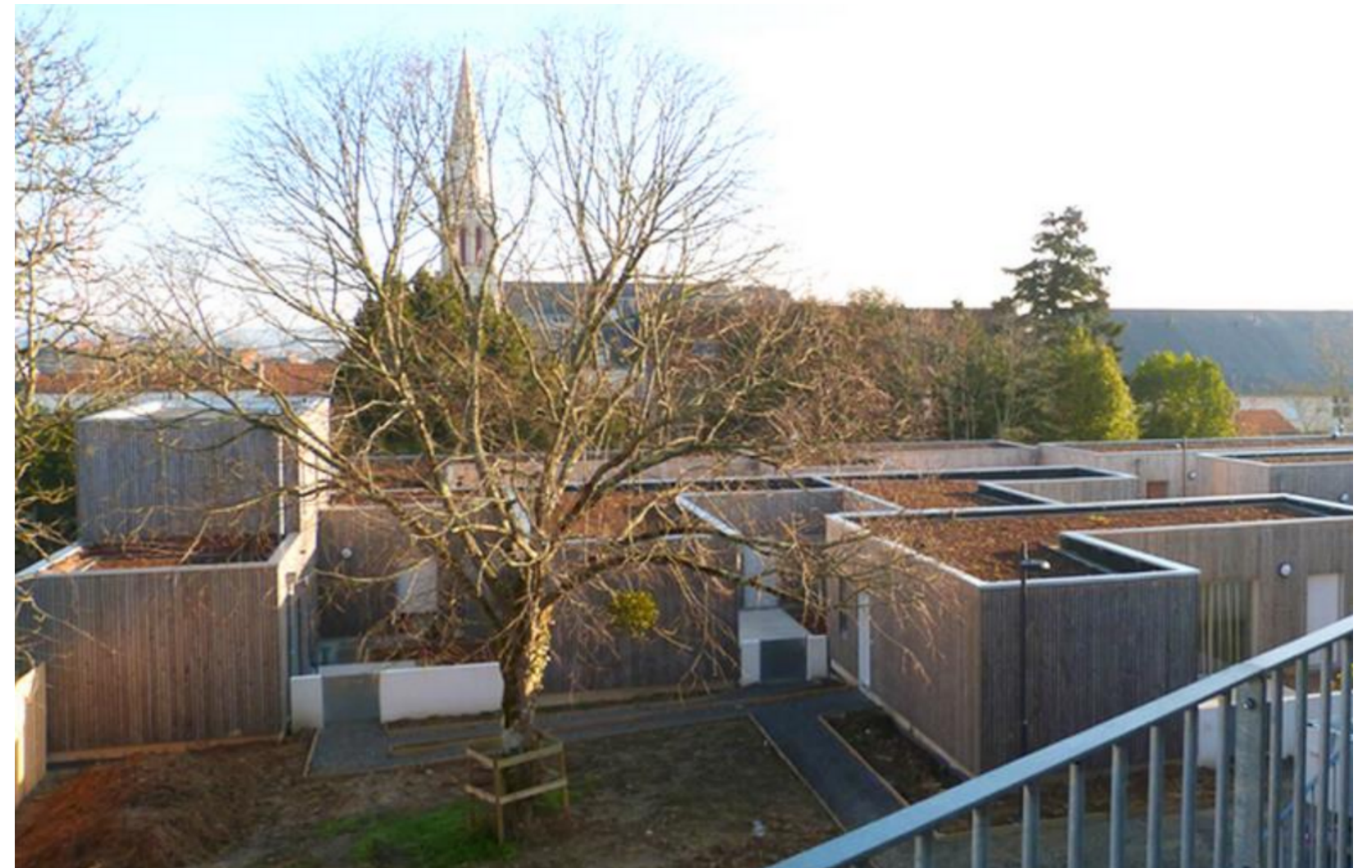
Résidence Tournesol, Le Pellerin (44) ©Observatoire CAUE
