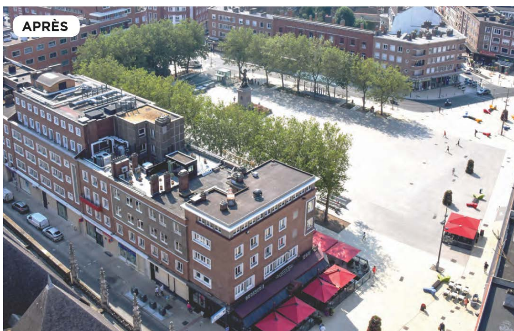
Figure 7 : La place Jean Bart après les travaux d'aménagement. Source : Projet DKPlus de Mobilité, Communauté Urbaine de Dunkerque
