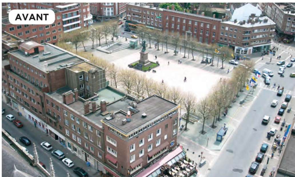
Figure 8 : La place Jean Bart avant les travaux d'aménagement
