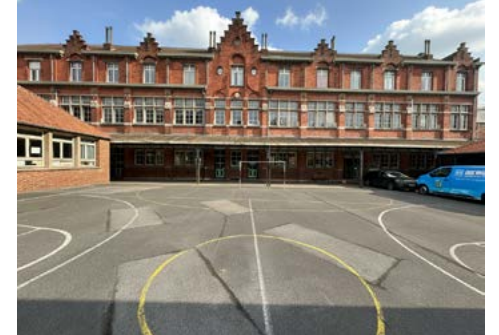
La cour de l'école Madame de Sévigné - état initial
