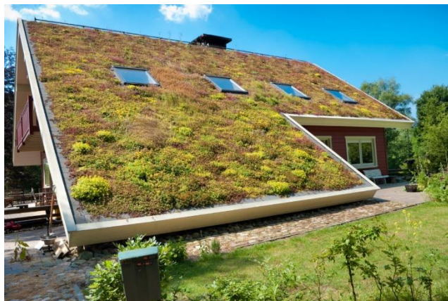
▲ Toiture végétalisée inclinée
