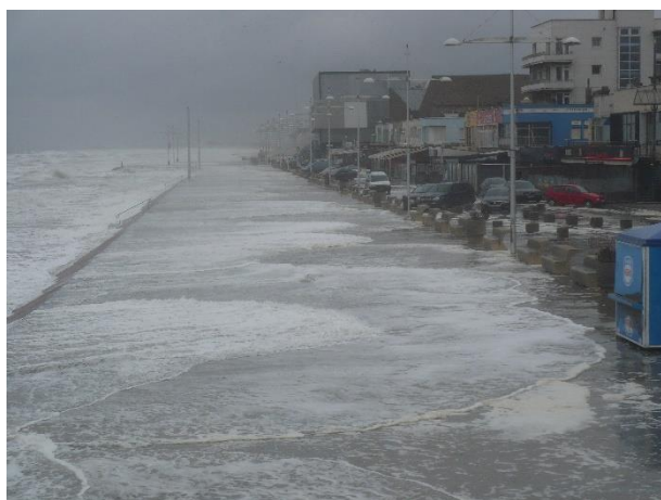
▲ Franchissement sur la digue de Malo-les-Bains
