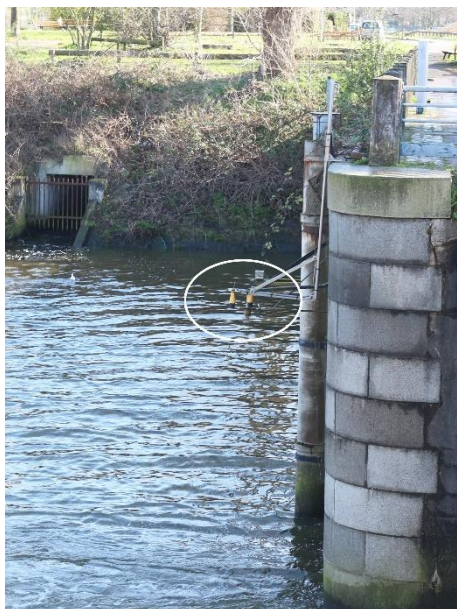
▲ Sondes de niveau d'eau
