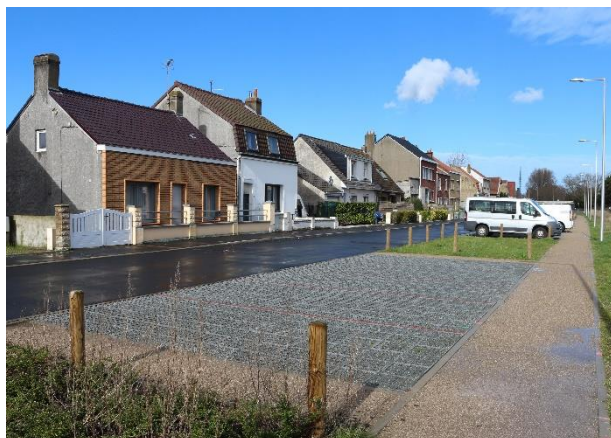
▲ Stationnement perméable pour infiltrer les eaux
