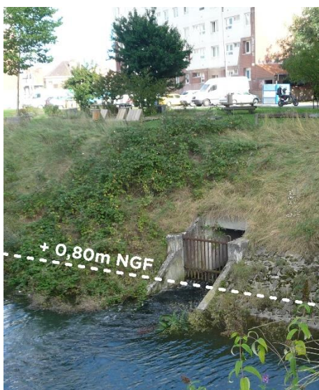
▲ Déversoir dans le canal
