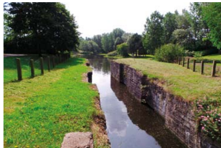
Ancienne écluse de Mardyck
