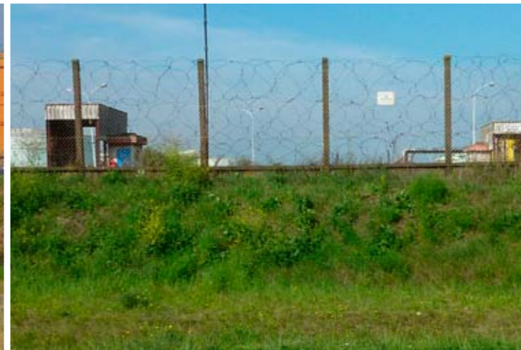
RAFFINERIE DES FLANDRES - route du Fortelet
