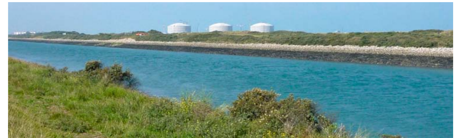
Cuves du terminal méthanier
