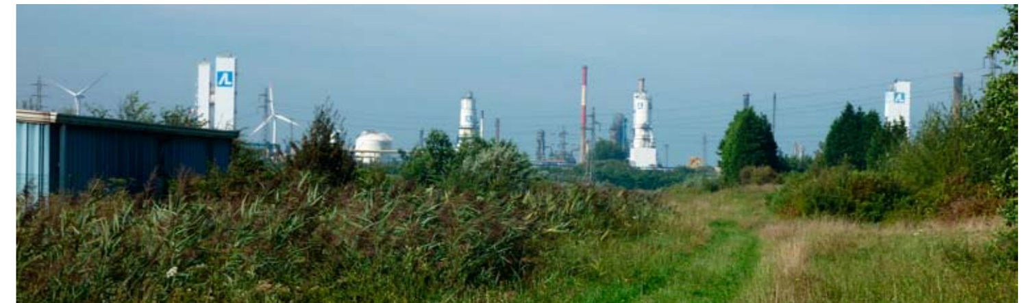
Installations de l'entreprise Air Liquide
