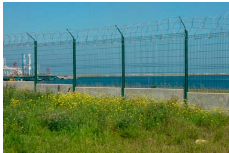
route du Fortelet
