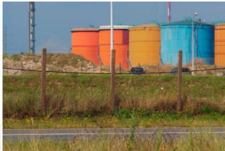
RAFFINERIE DES FLANDRES - route du Fortelet
