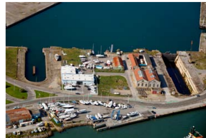
Usine des formes, forme n°3, forme n°5
