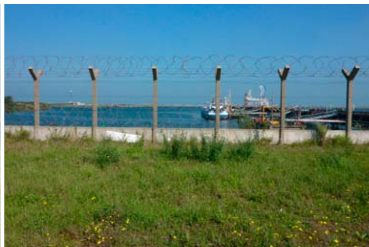
route du Fortelet
